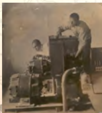
Возле первого электродвижка в с. Ижма Т.Е. Ануфриев (справа) и А.Е. Артеев
